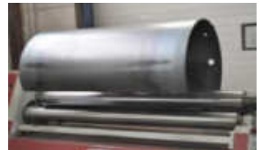
3. Biegen des Behälters
